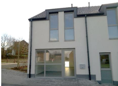
Vue d'ensemble / vitrine (RDC)
